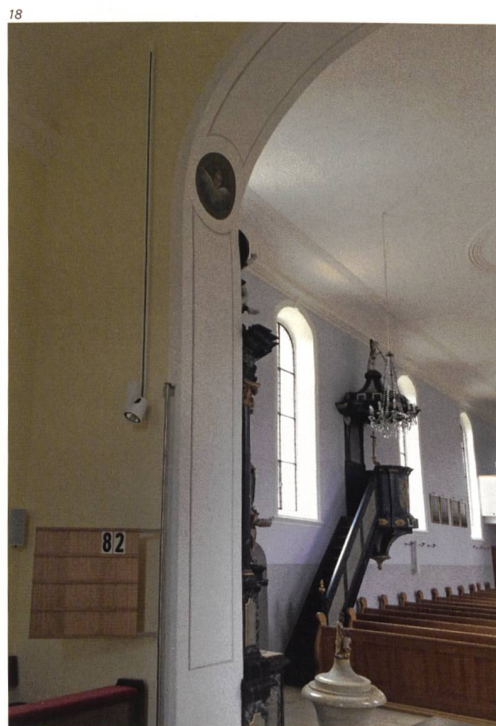
Abb. 18 Wandfassung nach der Restaurierung 2015 vom Chor aus Richtung Südwest des Schiffs: Gelbocker des Altarraums, Rahmung der historistischen Wandmalereien sowie Grauton der Sockelzone (ehemals Täfer) und Blaugrau der Wände im Schiff (ehemals Tapetenmalerei).
