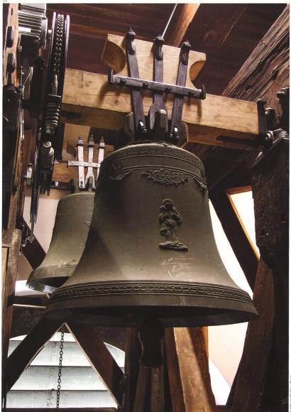
Verdickung in den Anschlagballen (in Ei- oder Kugelform) übergeht und schliesslich unterhalb des Ballens im sogenannten Vorschwung ausläuft. Während der Mittelpunkt des Anschlagballens unabhängig jeglicher Dimensionierungen immer auf jener Höhe liegt, dass er exakt auf den sogenannten Schlagring der Glocke – also deren dickste Stelle am unteren Rand – auftrifft, so können die übrigen Formen und Proportionen in der Praxis sehr unterschiedlich ausfallen.
