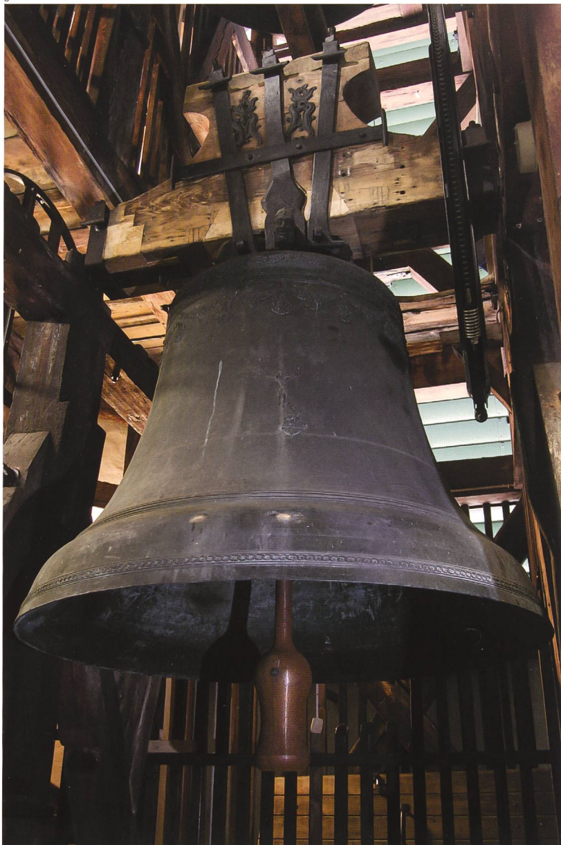
Abb. 8 Grosse Glocke mit dem restaurierten und ergänzten historischen Holzjoch. Die helleren Holzstellen sind als ergänzte Klötze aus Eichenholz gut sichtbar; die Metallblechzier wurde wieder montiert. Am eisernen Jochbeschlag und am Übergang vom Joch zur Glockenkrone mit Masken ist die nunmehr um ca. 20° gedrehte Aufhängeposition der Glocke nachzuvollziehen. Foto 2015.
