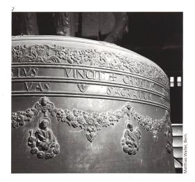
schi & Co. in Aarau die kleinere Vesperglocke (Nr. 10) durch einen Neuguss ersetzen, weil sie gesprungen war. Im Rahmen der Elektrifizierung des Geläuts 1929/30 wurde diese Glocke von derselben Giesserei abermals erneuert und aus musikalischen Überlegungen zugleich auch die Messglocke (Nr. 11) neu gegossen, weil die alte tonlich deutlich zu hoch steht. Die besagte Glocke (Nr. 12) hängt jedoch noch immer, wenn auch unbenutzt, in der obersten Glockenstuhletage (Abb. 16).
