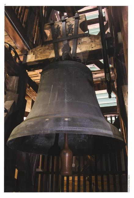
Abb. 8 Grosse Glocke mit dem restaurierten und ergänzten historischen Holzioch. Die helleren Holzstellen sind als ergänzte Klötze aus Eichenholz gut sichtbar: die Metallblechzier wurde wieder montiert. Am eisernen Jochbeschläg und am Übergang vom Joch zur Glockenkrone mit Masken ist die nunmehr um ca. 20° gedrehte Aufhängeposition der Glocke nachzuvollziehen. Foto 2015.
