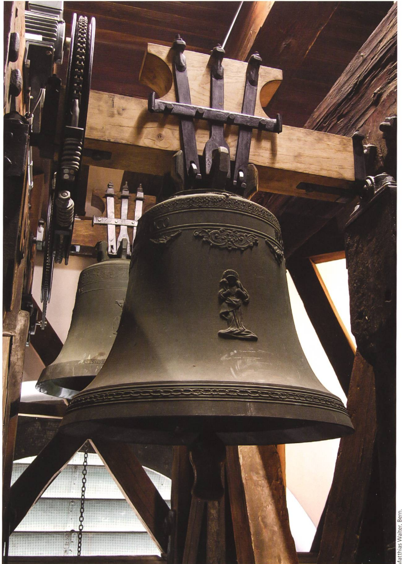
Abb. 10 und 11 Das 1930 neu gegossene Messglöcklein (Nr. 11) mit den teilweise von der Vorgängerglocke (Nr. 12) übernommenen Zier- und Figurenreliefs der Strahlenkranzmadonna und des Guten Hirten. Abb. 10 von 2008 zeigt die Glocke mit dem ursprünglichen Stahljoch, Abb. 11 von 2015 mit neuem Klöppel und neuem Holzjoch.
