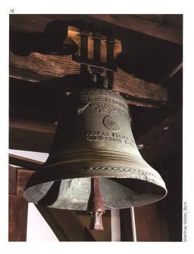
kanntlich deutlich zu hoch waren, markant gesenkt werden, sodass derzeit kein erhöhtes Risiko für Materialermüdung mehr besteht. Allfällige Umarbeitungen an den Klöppeln für ein optimiertes Resultat wären dank der überdrehten Oberfläche nach wie vor realisierbar. Abschliessend darf deshalb die Überzeugung ausgesprochen werden, dass die getroffenen Massnahmen eine aufrichtigere «Pietät gegenüber dem alten Meister» bedeuten als die 1963 erwogene, teilweise Bewahrung des bedeutenden Barockgeläuts.
