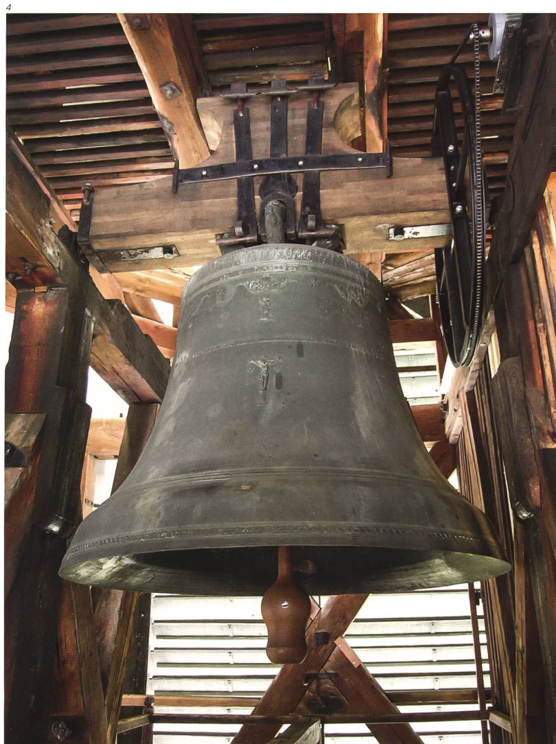
Abb. 4 Grosse Predigtglocke (Nr. 2) von 1766 im heutigen Zustand mit Holzjoch von 1991 und Klöppel von 2014.
