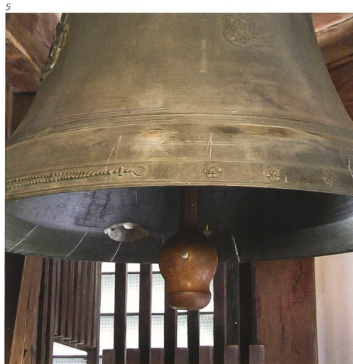
Abb. 5 Die Rosenkranzglocke (Nr. 6) von 1767, Detail des Schlagringes mit Abguss eines Rosenkranzes. Gut sichtbar die Drehung der Glocke: Links des neuen Klöppels die stark ausgeschlagene Stelle an der Kante, verursacht durch den ersten Klöppel, darin eine heller glitzernde Stelle vom neuen Klöppel von 2008; unmittelbar rechts des Klöppels Abdruck der neuen Anschlagstelle in heutiger, gedrehter Position. Foto 2015.
