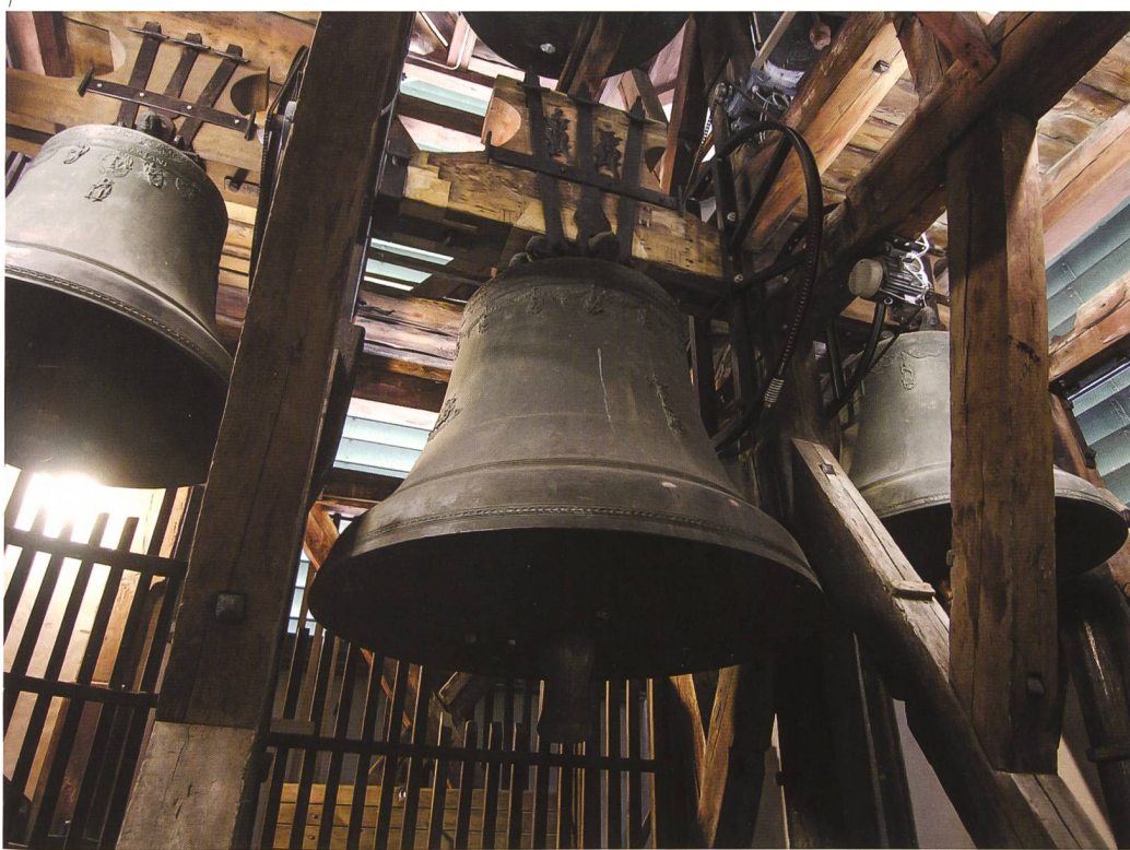
Abb. 1 Blick in den unteren Glockenstuhl mit den drei nebeneinanderhängenden Glocken Nrn. 4, 1 und 3 samt ihren restaurierten Armaturen. Foto 2015.
