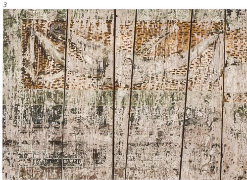
Abb. 4 Brüstungssegment des oberen Rangs nach der Freilegung. In einigen Bereichen wurden die Bretter bei nachträglichen Interventionen demontiert, verschoben oder ausgewechselt. Zum grössten Teil konnten sie aber wieder an ihren originalen Platz zurückversetzt werden.
