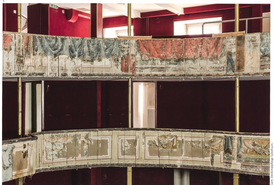
Abb. 1 Solothurn, Stadttheater. Zustand der Emporenbrüstungen nach der Abnahme der Damaststoffbespannung von 1936 und der Teilfreilegung des oberen Rangs.
