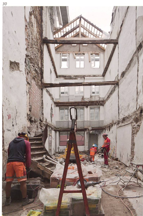
Abb. 30 Administrationsgebäude, Theatergasse 16. Aufgrund des schlechten Zustandes der alten Balkenlagen und der geplanten grossen Eingriffe für Lift, Treppen und sonstige Installationen musste das Gebäude aus-gekernt werden.
