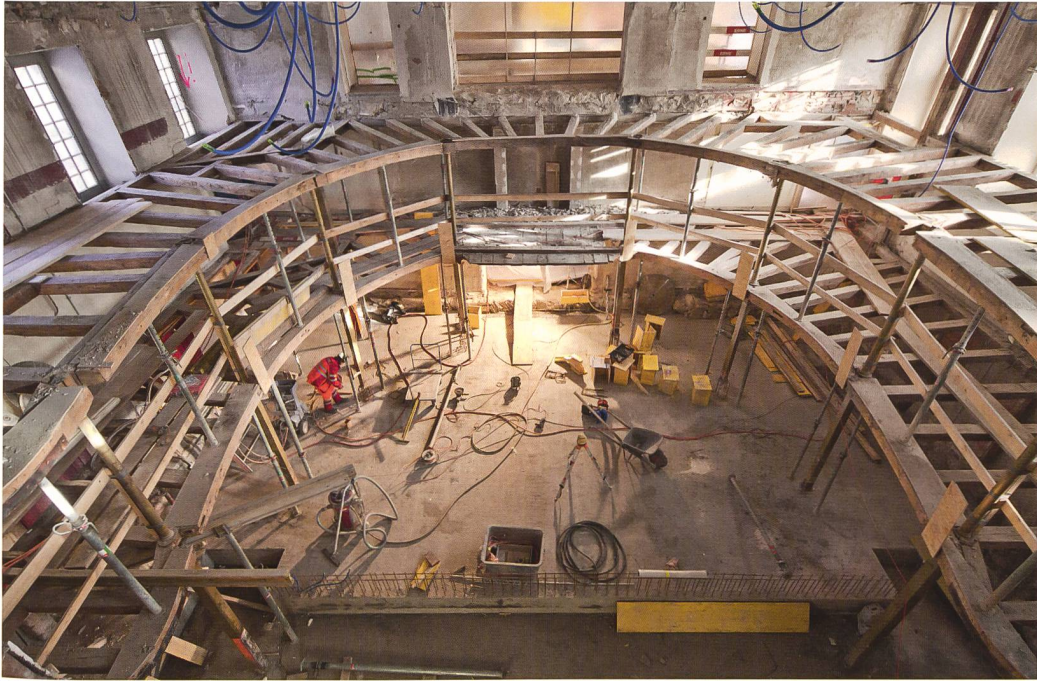
Abb. 25 Theatersaal, während der Bauarbeiten, 2013. Die Emporenbrüstungsbretter sind bereits demontiert. Gut sichtbar sind die Holzbalkenkonstruktionen der Emporen von 1778. Die schlanken Eisenstützen von 1856 ersetzen die quadratischen Holzstützen von 1778. Ihre Lage und Dimension ist an den zum Teil gefüllten Aussparungen im äusseren Holzbalkenring noch zu erkennen.
