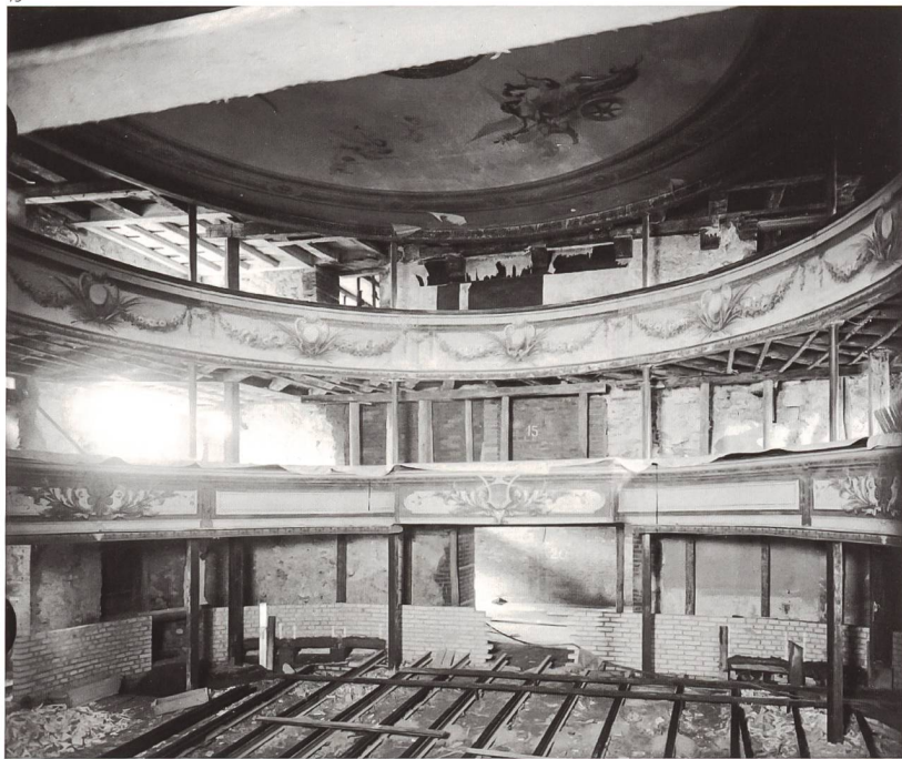
Abb. 19 Theatersaal und Emporen während des Umbaus von 1936. Sichtbar sind die Brüstungsdekorationen von 1894. Es handelt sich wahrscheinlich um bedruckte Gewebefolien, geliefert von Franz Anton Zetter-Collin. Die Dekoration wurde 1936 entfernt. Die allegorischen Deckenmalereien stammen von Gustav Bogsch, Dekorationsmaler aus Deutschland.
