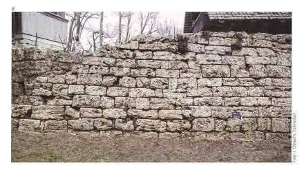
Abb. 8 Mauer M26 aus Tuffsteinquadern nach der Entfernung des Pflanzenbewuchses und der Moospolster. Aufnahme 2012; von Norden.
