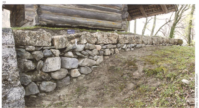
Abb. 10 Freiliegendes Fundament der Mauer M24. Es besteht mehrheitlich aus kristallinem Steinmaterial. Aufnahme 2012; von Nordwesten.
