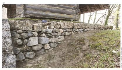
Abb. 10 Freiliegendes Fundament der Mauer M24. Es besteht mehrheitlich aus kristallinem Steinmaterial. Aufnahme 2012; von Nordwesten.
