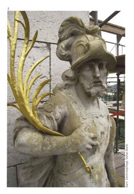
tiert. Man entschied sich damals, die Neufassung nicht mehr mit Ölfarbe durchzuführen, sondern mit einem Anstrich aus Mineralfarbpigmenten und einem Zusatz von 4 % Wasserglas. Diese wurde 1979 durch einen Restaurator auch so ausgeführt. Der Anstrich wurde anschliessend nach mehrwöchiger Trocknungszeit mit nicht hydrophobiertem Kieselsäureester fixiert.
