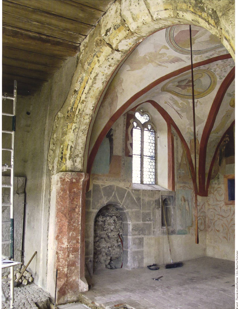
Abb. 16 Chorbogen während der Renovation. Zustand nach dem Abbruch der nachträglichen Ausmauerung. Blick gegen innen auf die Nordmauer des Chores, in der Mitte die ehemalige Sakristeitür.
