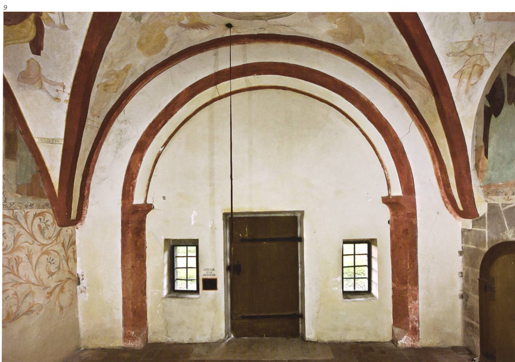
Abb. 9 Innenansicht der Westwand. Restauriert 1937, Zustand vor dem Ausbruch der Chorbogen- ausmauerung 2010. Chorbogen mit breiter Abfasung, Kämpfer und Rundbogen aus der Phase III, erstellt anlässlich des Neubaus des grösseren Schiffs III. Vermauert wurde der Chorbogen beim Abbruch des Schiffs. Dabei wurde der Chorbereich zur eigenständigen kleinen Kapelle.
