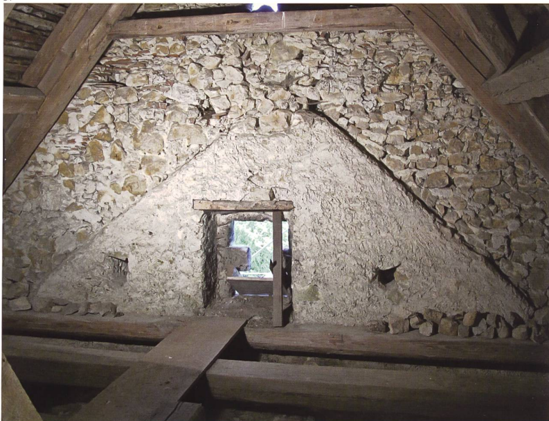
Abb. 31 Dachstock, Blick zur Ostmauer. Gut erkennbar ist das alte Giebelmauerwerk mit der dazugehörenden Dachneigung. Die Giebelmauer wurde in zwei weiteren Bauetappen erhöht.
