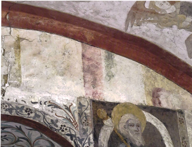
Abb. 18 Ostmauer des Chores, beim Anschluss an das Gewölbe. Zustand während der Renovierung. Unten die originale Apostelmalerei, mit dem Anschluss an die ehemalige gerade Bretterdecke. Darüber der erhaltene Restbereich der Wandausmalung zum nachträglichen Kreuzgratgewölbe. Das rote Abschlussband des Gewölbes stammt aus der Zeit der Restaurierung von 1937.
