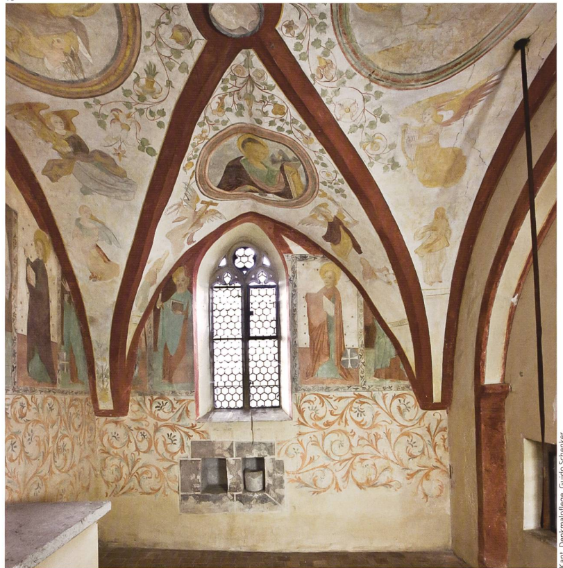
Abb. 10 Innenansicht der Südwand. Restauriert 1937, Zustand vor der erneuten Teilrestaurierung 2010. Doppelnische mit Quadermalerei I, bemalte Sockelzone und Apostelzyklus II. Masswerkfenster und Kreuzgratgewölbe mit Malerei IV.
