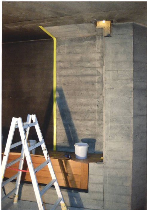
Abb. 25 Für die Submission erstellte Musterfläche im Kirchenraum. Links der gelben Markierung die verschmutzte Oberfläche, rechts davon das Reinigungs- muster.
