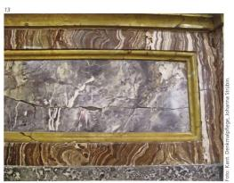
Abb. 14 Kanzelkorb, Detail. Die Relieffelder aus weissem Alabaster am Kanzelkorb sind von Goldleisten eingefasst und mit «Marbre Rouge Incarnat du Languedoc» N°9 gerahmt. Pilaster aus «Marbre Jaspe Rouge» N°2 trennen sie, die waagrechten Abschlussgesimse sind aus «Marbre Gris Porcelin» N°1, besser als Gris de Roche bekannt. Die Rückwand der Kanzel und die eingezogenen Felder des gestuften Kanzelfusses sind aus «Marbre Choin jaune et rouge de Parve» N° 5.
