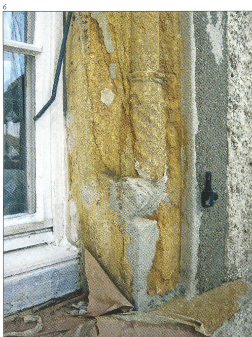
Abb. 7 Farbsondierung an einer Lisene des Kanzleisaals. Der Befund zeigt deutlich die dunkelgraue, fast schwarze Originalfassung, die wieder hergestellt wurde.
