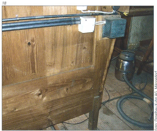
Abb. 18 Innenseite der Gehäusefront mit Ausschnitten, die schräg nach unten auf das Aussen- mass der Pedalklaviatur verlaufen, darüber Elektro- installationen.
