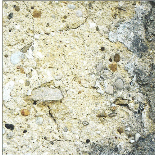
Abb. 28 Nordfassade, im Bereich des alten Turmes. Erhaltener Verputzmörtel von 1408. Der trocken gelöschte Kalkmörtel weist eine teilweise grobe Körnung auf, auch die vielen kleinen Kalkeinschlüsse (Kalkspatzen) sind typisch für einen Verputz aus dieser Zeit. Die Oberfläche witterte im Laufe der Jahrhunderte ab, die Festigkeit ist aber immer noch erstaunlich gut.
