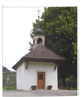
nung an die ursprüngliche Gestaltung mit Holzschindeln verkleidet worden. 2010 mussten die instabile Konstruktion des Dachaufbaus, die Kupferverkleidung des Zwiebeldachs und die schadhafte Verkleidung mit Holzschindeln instand gestellt werden. Gleichzeitig wurde auch die Geläutmechanik überholt.
