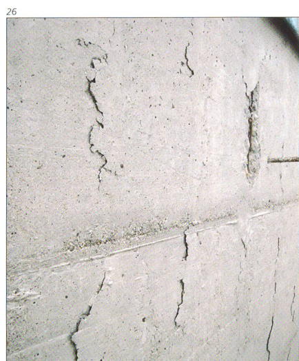
Abb. 26–28 Typische Schadensbilder an den Sichtbetonfassaden: Risse, schalenartige Abplatzungen, korrodierte Armierungseisen.
