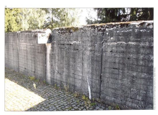
Abb 31 Stark beschädigte Umfassungsmauer des Zugangshofes, vor der Restaurierung
