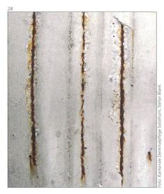
Abb. 26-28 Typische Schadensbilder an den Sichtbetonfassaden: Risse, schalenartige Abplatzungen, korrodierte Armierungseisen.
