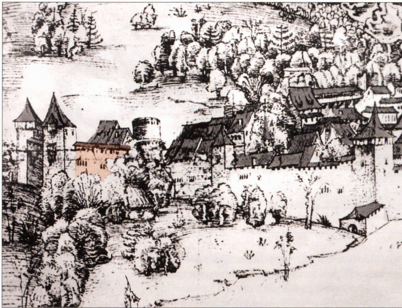
Abb. 4 Ausschnitt aus der ältesten Stadtansicht von Solothurn von Urs Graf, um 1508/1510. Abschnitt der mittelalterlichen Stadtmauer zwischen dem Bieltor und dem südlichen Schalenturm, dahinterliegend die Schmiedengasse. Regelmässiger Zinnenkranz mit ziegelgedecktem Wehrgang. In der Mitte ist ein kleiner Wehrmauererker sichtbar.
