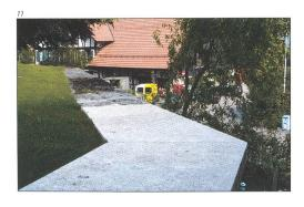
steinplatten erneuert. Nach genaueren Abklärungen für eine bautechnisch und auch ästhetisch befriedigende Lösung wurde wieder eine Abdeckung mit witterungsbeständigen Natursteinplatten gewählt. Diese Ausführung fügt sich sehr gut in die Situation und ist Beispiel für die Sanierung weiterer Partien der Kirchenmauer.
