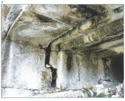
bossierten Quadern mit sauberem Randschlag gemauert. Die Bossierung ist jedoch nicht einheitlich. Man findet von einer relativ sauber gehauenen regelmässigen und nur leicht auskragenden Bossierung bis hin zur fast noch rohen und bis zu 40 Zentimetern auskragenden alle Varianten (Abb. 9). Die
