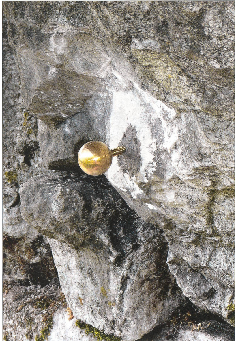
Abb. 20 Einer der rund zwanzig über das gesamte Mauerwerk verteilten Messing-Mess- punkte. Mit ihnen können bereits kleinste Verschiebun- gen an den Quadern und Fugen gemessen werden.
