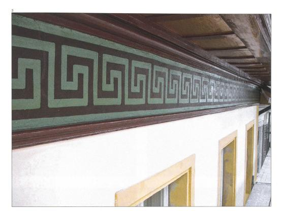
Abb. 5 Dachuntersicht und Fries nach der Restaurierung 2008.
