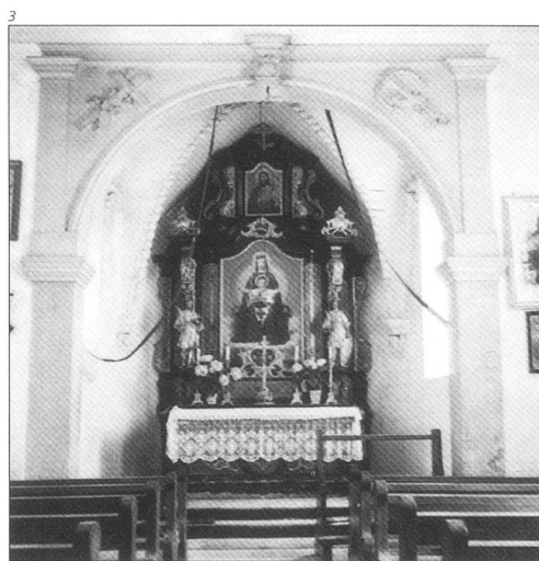
Abb. 3 u. 4 Das Kapelleninnere vor der Renovation von 1974/75. Die Stuckaturen an Wänden, Decken, Chorbogen und Chorgewölbe sowie die Empore über dem Eingang wurden damals entfernt.
