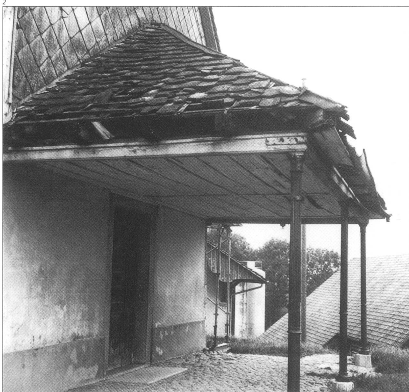
Abb. 2 Das Vorzeichen mit den gusseisernen Säulen von 1877 wurde bei der Renovation von 1974/75 durch das heute noch bestehende Pultdach mit Steinsäulen ersetzt.
