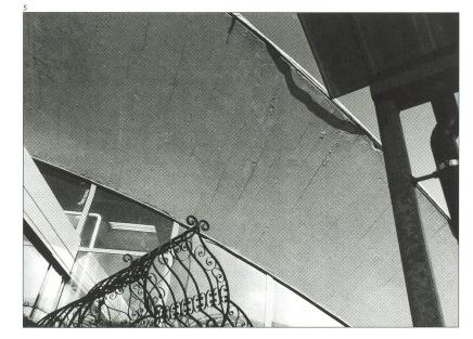
auftrags nicht mehr möglich. Lediglich an einigen wenigen Stellen ist die originale Schalungsstruktur noch sichtbar erhalten (Abb. 5). Abschliessend wurde sowohl an der Schalenoberseite als auch an der Unterseite der Vordächer ein weisser Schutzanstrich angebracht.
