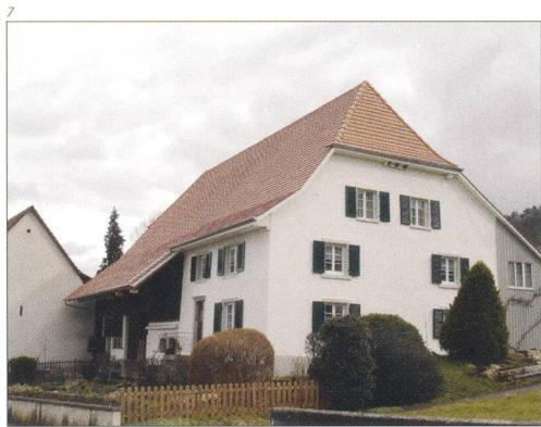
haus Leimenstrasse 6 steht vis-à-vis der Kirche und dem Pfarrhaus im Herzen des Dorfes. Bei der Sanierung des fast 600 Quadratmeter grossen Daches wurden wieder die für Leimentaler Dörfer typischen Bibernschwanzziegel verwendet.
