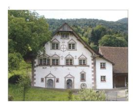
gestützte Flugsparrenwerk freigelegt worden. Nach über einem halben Jahrhundert bedurften die verzierten Giebelfassaden 2006 einer Restaurierung. Die Natursteine, der Fassadenverputz und die Malereien wurden sorgfältig gesichert, restauriert und wo nötig in zurückhaltender Art ergänzt, so dass die lebendige Frische der Fassade wieder schön zum Ausdruck kommt. MARKUS SCHMID
