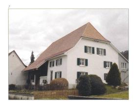
haus Leimenstrasse 6 steht vis-à-vis der Kirche und dem Pfarrhaus im Herzen des Dorfes. Bei der Sanierung des fast 600 Quadratmeter grossen Daches wurden wieder die für Leimentaler Dörfer typischen Biberschwanzziegel verwendet.
