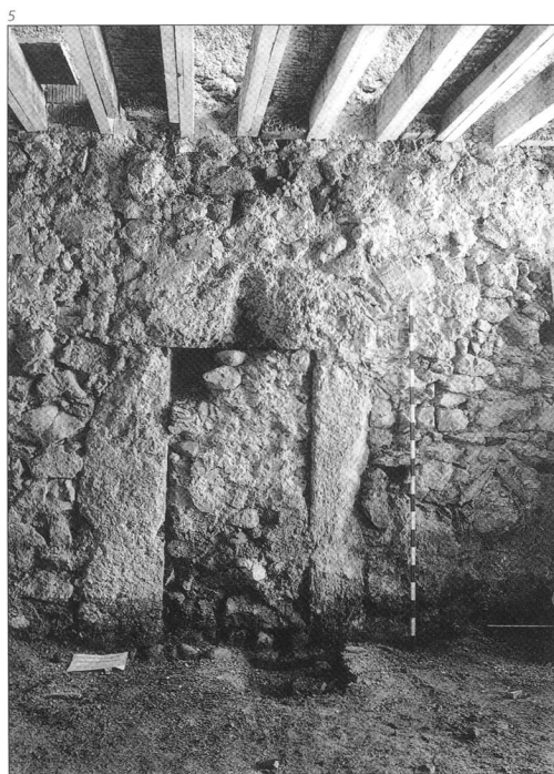
Abb. 5 Brandmauer Süd, Mauerwerk der zweiten Bauphase im Bereich Erdgeschoss, mit zugemauelter Türöffnung und sekundär eingesetzter Lichtnische daneben.
