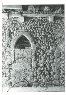
Abb. 5 Zugemauerte Spitzbogentür, im Mauerwerk der ersten Erweiterung des Konventgebäudes als breite Rundbogentür konstruiert. Der leicht asymetrische Spitzbogen entstand erst anlässlich einer späteren Verschmälerung der Tür.
