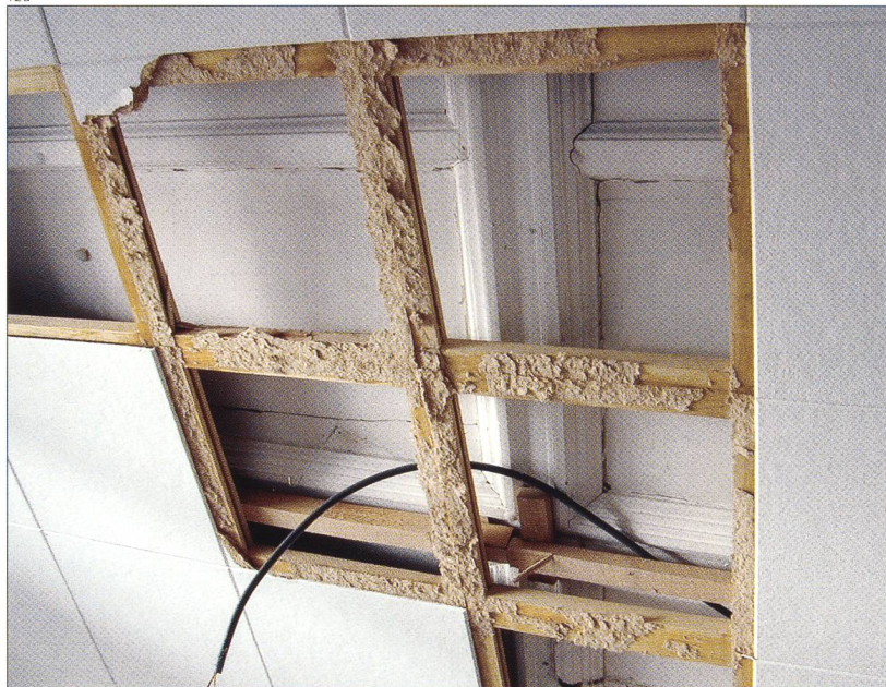
Abb. 12 Barfüssergasse 13, 3. Ober- geschoss, Täferdecke von 1641, Fundzustand, Profil Mittelfries und Deckleiste.
