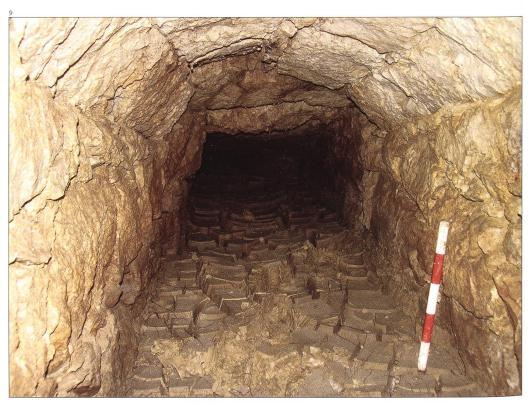
Gang war aus länglichen, grob zugehauenen Kalksteinblöcken errichtet. Stadtseitig, an der höchsten Stelle, war die Decke mit grossen Quadersteinen gewölbt, feldseitig war die Decke flach (Abb. 9). Sie fiel steil gegen den Schanzengraben hin ab. Im steileren Nordteil war der Boden mit viel Schutt bedeckt. Im Süden, wo das Gefälle abnahm, lag eine dicke Lehmschicht. Die Höhe des Kanals betrug 75 bis 150 Zentimeter, der ursprüngliche Boden war aber nirgends sichtbar.
