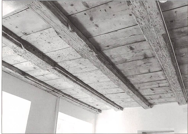
Abb. 6 Die Decke über dem Foyer mit fein profilierten Balken und eingeschobenem Blindboden aus überfälzten, glatt gehobelten Brettern stammt aus der Bauzeit von 1580. Zustand nach der Freilegung und Reinigung.
