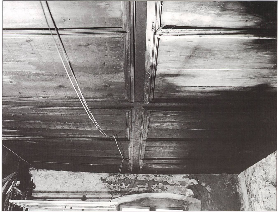
Abb. 9 Täferdecke im ehemaligen Saal im 1. Obergeschoss. Die mit feinen parallelen Ritzlinien dekorierten Tafeln sind in einem Raster von profilierten Deckleisten eingefügt. Decke aus der Bauzeit von 1594 im Zustand nach vierhundert Jahren, 1999.
