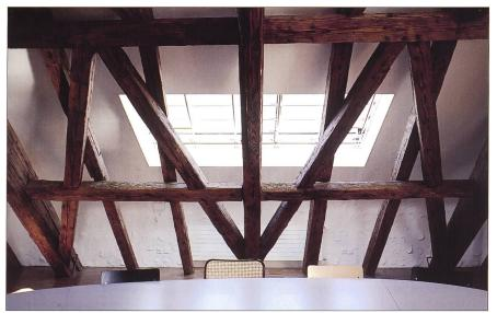
**Abb. 4** Die intakt erhalten gebliebenen Windverstrebungen in der nördlichen Dachfläche mit dem neuen Fenster in der Dachfläche.
