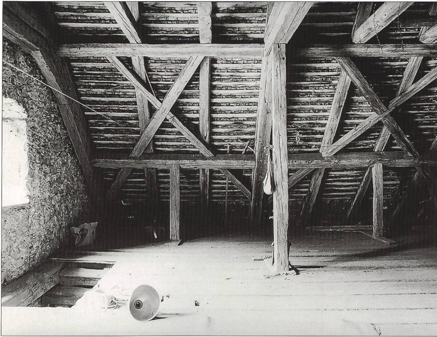
Abb. 12 Die weitgehend intakte Dachkonstruktion mit sogenannten «Andreaskreuzen», die als Windverstrebung dienen. Der liegende Dachstuhl ist laut Arbeitsvertrag 1594/95 von Wer(n)li Meyer aus Erschwil gefertigt worden. Zustand 1999.
