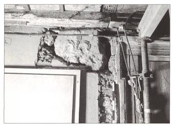
**Abb. 5** Befund über der ehemaligen Tür zum Treppenturm. Der lilienförmige Dekor ist in ein Werkstück aus Hauterivestein gehauen, er ist wahrscheinlich Teil einer früheren Türrahmung aus der Bauzeit von 1580. Rechts die um die Mitte des 17. Jahrhunderts neu erstellte Tür zum Treppenturm.
