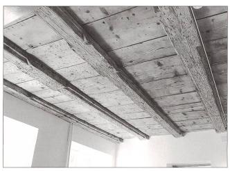
**Abb. 6** Die Decke über dem Foyer mit fein profilierten Balken und eingeschobenem Blindboden aus überfälzten, glatt gehobelten Brettern stammt aus der Bauzeit von 1580. Zustand nach der Freilegung und Reinigung.
