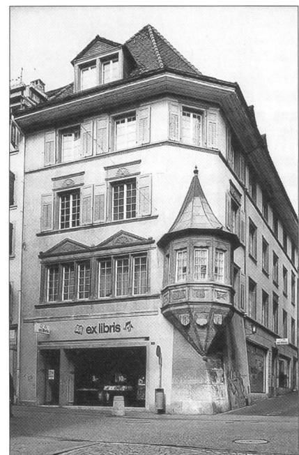
Abb. 2 ... und 2003 im Zustand nach den Umbauten von 1920 und später.
