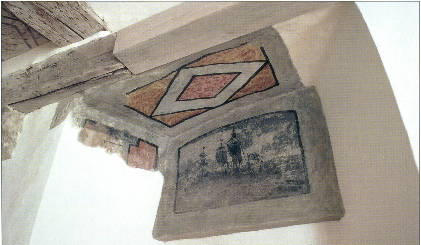
Abb. 3 Supraportenmalerei und Rest der Leibungsdekoration über der einstigen Gartentür nach Osten, nach der Restaurierung.
