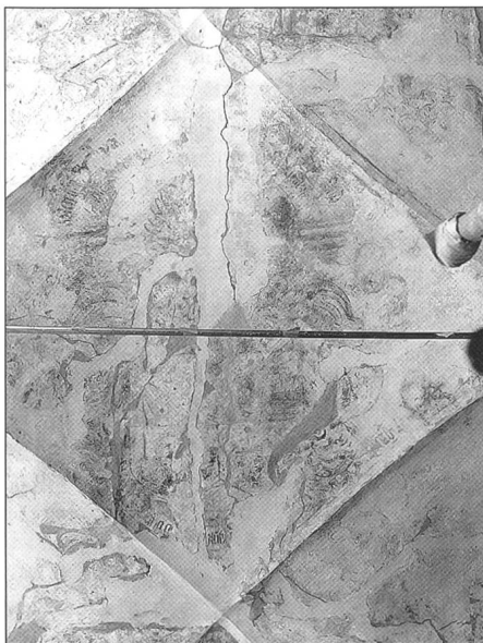
Abb. 5 Wappen von Martin Besenval, Zustand nach der Freilegung...
