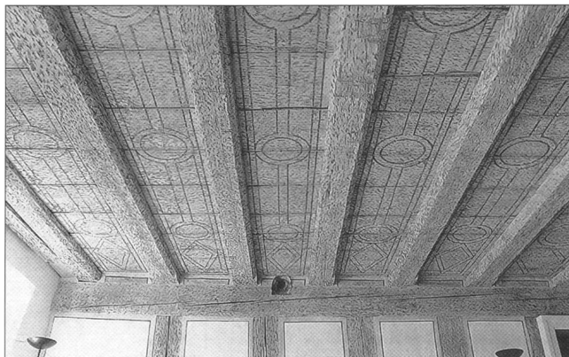
Abb. 2 Die Balkendecke nach der Restaurierung von 2003.
