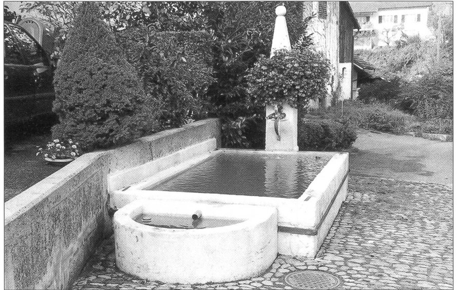
Abb. 1 Bärschwil, Natursteinbrunnen mit Rechteckbecken und halbrundem Waschtrog.
