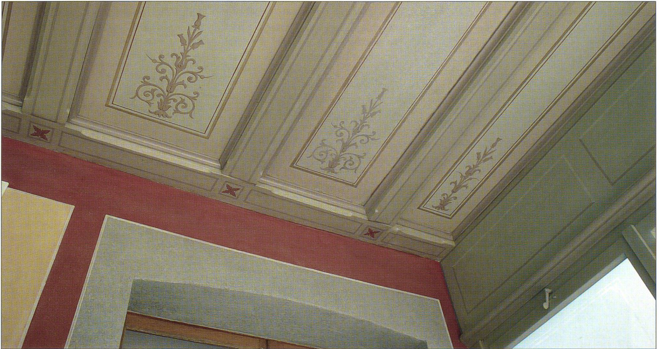
Abb. 3 Detail der freigelegten Deckenmalerei im Innern.
