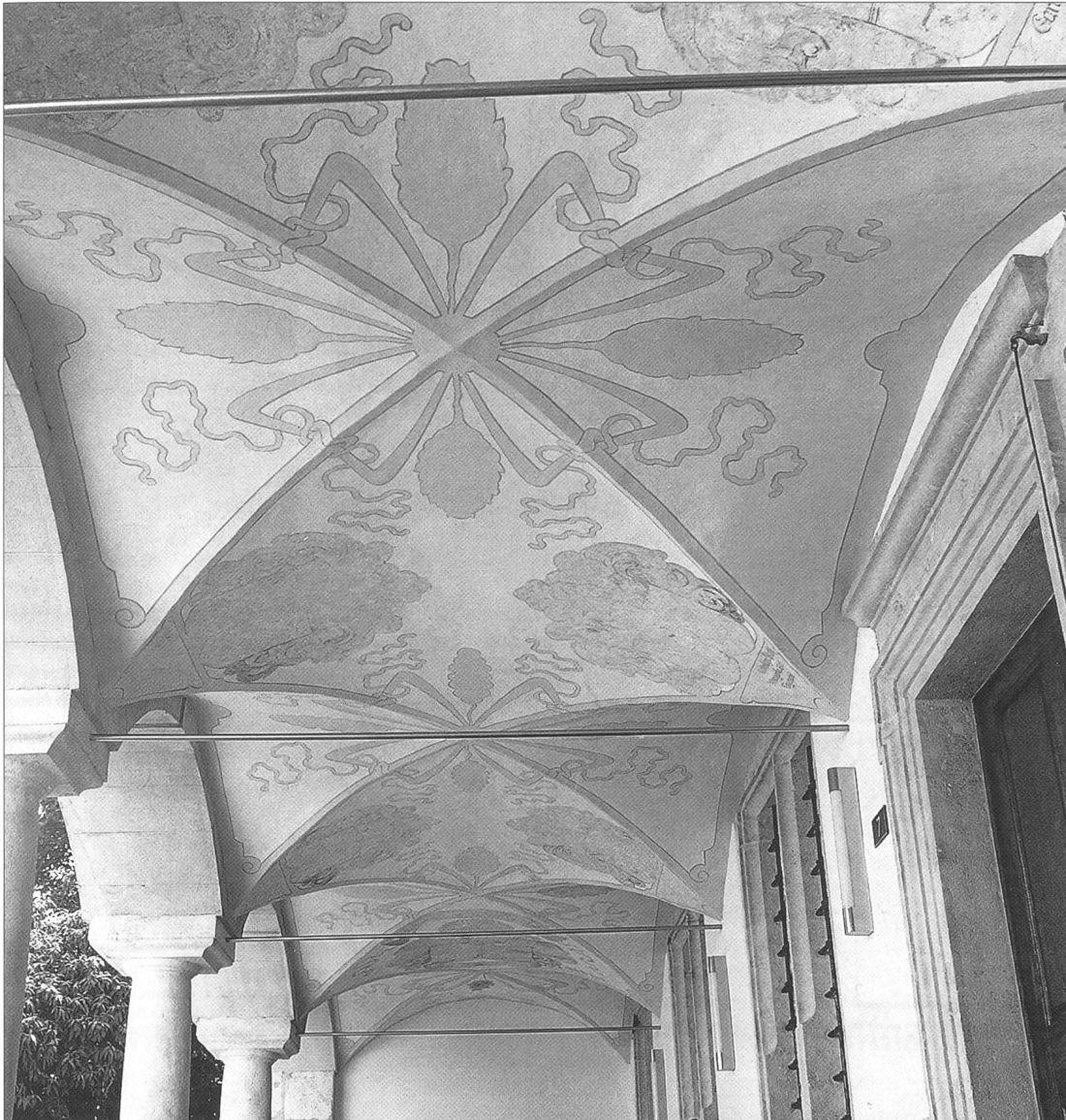
Abb. 4 Das dekorativ ausgemalte Gewölbe nach der Restaurierung/ Rekonstruktion von 2003.
