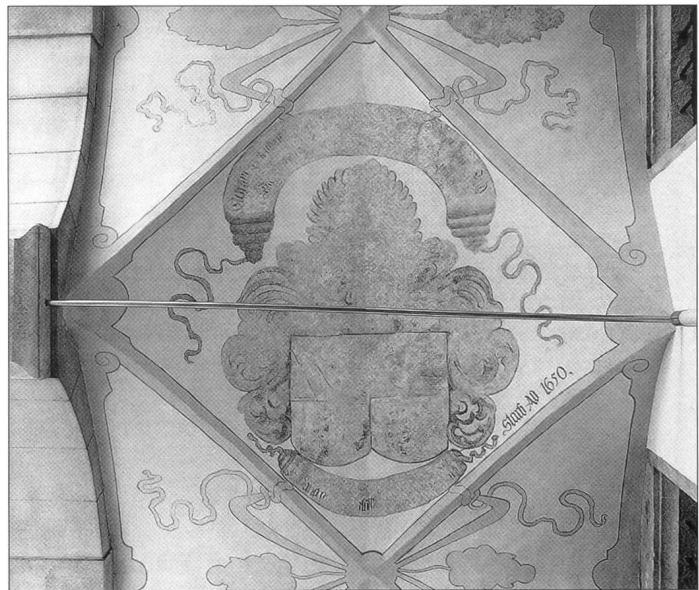
Abb. 6 ... und nach der Restaurierung von 2003.
