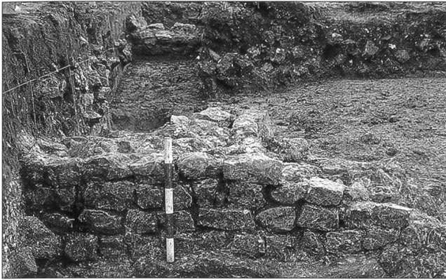
Abb. 9 Dornach/Kohlberg 6. Die Hofmauer M4 von Westen (ausseen) im Bereich des Steintraktes I. Der Fundamentvorsprung und vier Lagen des aufgehenden Mauerwerks sind zu erkennen.
