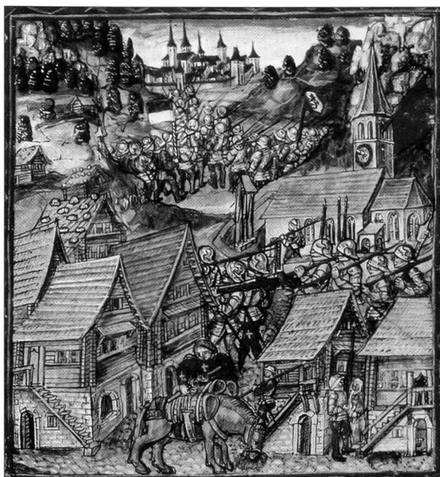
Abb. 13 Beleg einer Aussentreppe in der «Luzerner» Chronik des Jüngeren Diepold Schilling aus dem beginnenden 16. Jahrhundert. Über einem gemauerten Erdgeschoss liegen hölzerne Wohngeschosse in Blockbautechnik. Ins Obergeschoss gelangte man über eine hölzerne Treppe. Diepold Schilling Chronik 1513, 93r; ZHB Luzern (Eigentum Korporation).
