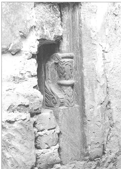
Abb. 8 Profiltotlauf am ehemaligen Dreierfenster im 2. Obergeschoss des Hinterhauses, 16. Jahrhundert.
