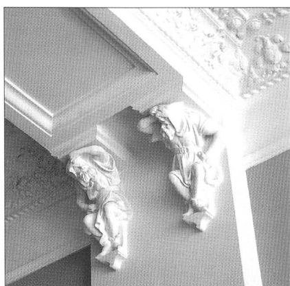
Abb. 4 Detail Konsole am Unterzug in der Raummitte.
