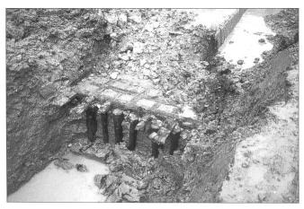
Abb. 43 Solothurn/Dornacherplatz. Balkenrost und Pfählung unter der Schanzenmauer in Etappe 2. Von Südosten.
