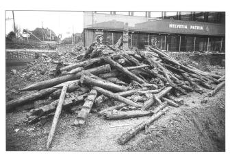
Abb. 44 Solothurn/Dornacherplatz. Herausgerissene Balken und Pfähle aus dem Fundament der Schanzenmauer.
