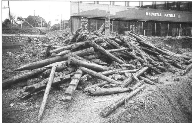
Abb. 44 Solothurn/Dornacherplatz. Herausgerissene Balken und Pfähle aus dem Fundament der Schanzenmauer.
