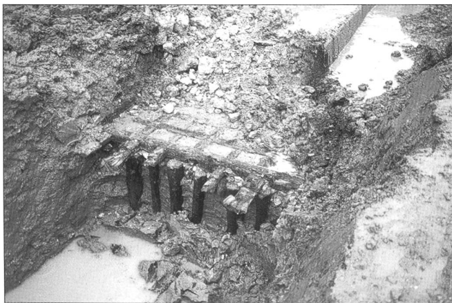
Abb. 43 Solothurn/Dornacherplatz. Balkenrost und Pfählung unter der Schanzenmauer in Etappe 2. Von Südosten.
