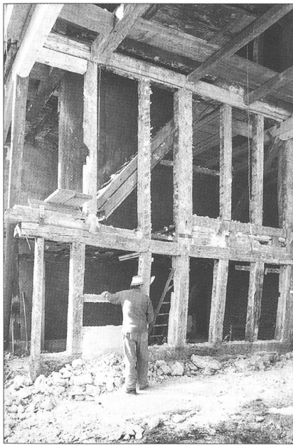
Abb. 5 Die westliche Seitenwand im Tenn, während dem Abbruch 1998. Bereits sind die gemauerten Ausfachungen entfernt. Nachweisbar bestand die Wand anfänglich aus einer Bohlen-Ständerkonstruktion, sie wurde erst zu einem späteren Zeitpunkt mit Mauerwerk ausgefacht.
