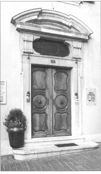
**Abb. 8** Die Haustür. Gewände aus der Bauzeit von 1682/83, Türblätter wahrscheinlich rund hundert Jahre jünger. Die Profilformen sind dieselben wie im Täferzimmer (Abb. 5, 6).
