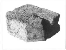
**Abb. 16** Formbacksteine aus dem Mauerwerk der Nordfassade von Bau VIII (Abb. 15). Es handelt sich um Elemente zur Konstruktion von gefasten Fenster- und Türgewänden in der Tradition der St.-Urban-Backsteine. Höhe 11 cm, Breite 24,5–25 cm, Tiefe 19–20 cm (13. Jahrhundert?).
