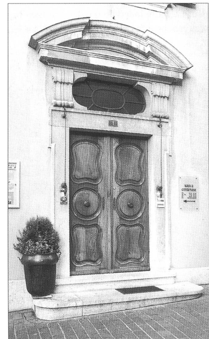
Abb. 8 Die Haustür. Gewände aus der Bauzeit von 1682/83, Türblätter wahrscheinlich rund hundert Jahre jünger. Die Profilformen sind dieselben wie im Täferzimmer (Abb. 5, 6).
