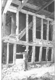
während dem Abbruch 1998. Bereits sind die gemauerten Ausfachungen entfernt. Nachweisbar bestand die Wand anfänglich aus einer Bohlen-Ständerkonstruktion, sie wurde erst zu einem späteren Zeitpunkt mit Mauerwerk ausgefacht
