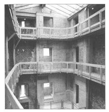
Abb. 5 Innenraum nach der Restaurierung mit neu aufgeführter Mauerecke, Holzgerüst mit Stabilisierungsringen (gleichzeitig Galerien) und Glasdach
