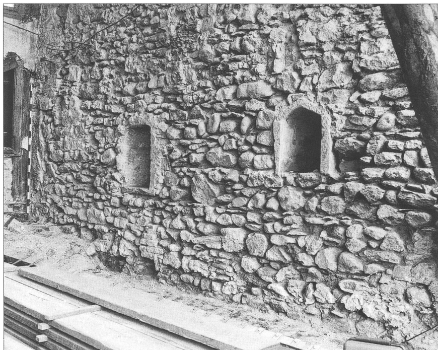
Abb. 14 Brandmauer Ost, nach der Freilegung im Rahmen der Bauuntersuchungen von 1998. Im unteren Teil die stark brandgeschädigte Wand von Bau IV, darüber Mauerwerk von Bau V mit unregelmässiger Abbruchkrone auf die der Giebel zur Scheune von 1588 aufgesetzt ist.
