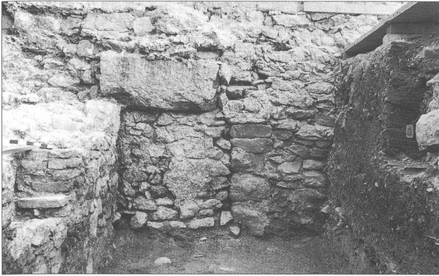
Abb. 9 Befund im Fundament der östlichen Brandmauer. Zwischen den Resten der beiden Bauten I (links) und II (rechts) sitzt ein jüngeres, trocken gesetztes Mauerwerk (Bildmitte), das eine Chronologie nach bautechnischen Gesichtspunkten verunmöglicht.
