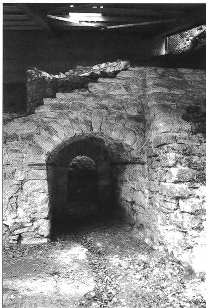
Abb. 3 Südlicher Ofen mit Bedienstollen (vorne) und trichterförmigem Ofenschacht (hinten), nach der Restaurierung.
