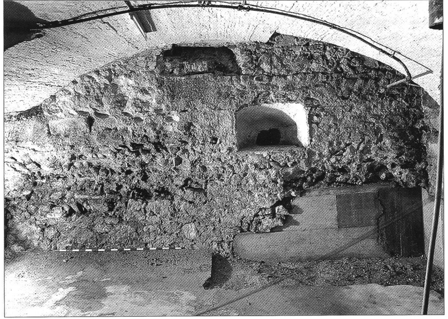
Abb. 6a Solothurn, Schmiedengasse 5, 1842 erneuerter Gewölbekeller, Blick nach Süden. Bei den steinsichtigen Partien handelt es sich um Mauerwerk der römischen Castrumsmauer (rechts) und einem dazugehörigen Turm (links).
