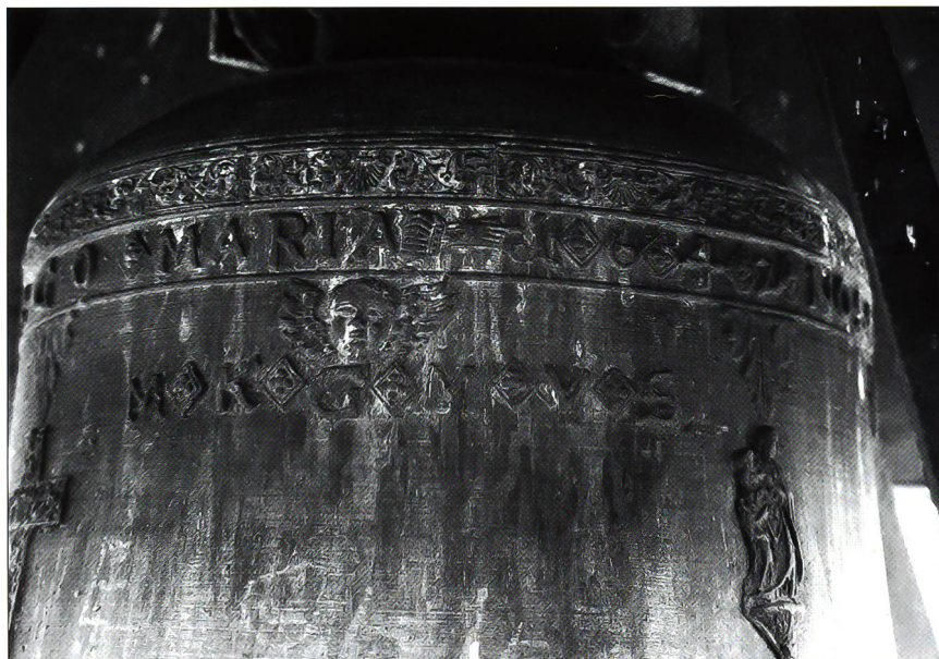
Abb. 24 Mit dem Einbau des Viertelstunden-Schlagwerks wurde eine zweite Glocke nötig, die unter die ältere Stundenglocke montiert wurde. Sie ist 1642 datiert und mit M.K.G.M.V.S. signiert.
