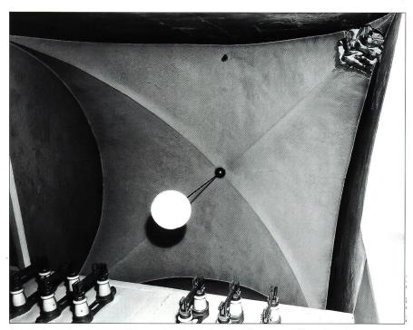
**Abb. 3** Das Erdgeschoss des Turms erstreckt sich über die Höhe von zwei Normalgeschossen. Es war bis 1960 mit diesem Kreuzgratgewölbe aus grossformatigen Backsteinen überdeckt. Aufnahme vor dem Abbruch, der im Zusammenhang mit dem Einbau einer Transformatorenstation erfolgte.
