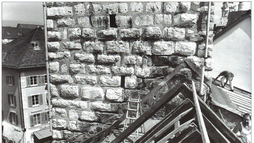
Abb. 6 3. Obergeschoss Westseite. Die grob zurechtgehauenen Quader besitzen bossierte Sichtflächen, die von einem schmalen Randschlag begleitet sind. Die Bossen zeigen zum Teil natürliche Oberflächen, zum Teil sind sie mit schlichten Methoden künstlich geformt. Quader ohne Bossen, hier in den beiden obersten Steinlagen des Bildausschnitts, entstanden durch nachträgliche Abarbeitungen im Zusammenhang mit der Errichtung von Zifferblättern.
