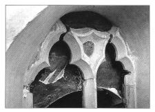
**Abb. 45** Chor, Fenster Südost, Masswerkabschluss. Zustand während der Restaurierung, 1995. Durch Bewegungen im Mauerwerk sind die Werkstücke voneinander gewichen.
