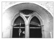
**Abb. 43** Chor, Fenster Süd, Masswerkabschluss. Zustand während der Restaurierung,
