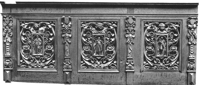
**Abb. 22** Brüstungselement des ehemaligen Lettners. Entstanden um 1643 im Zusammenhang mit dem frühbarocken Umbau der Kirche 1643–1645. Im Zentrum der jeweils aus einer einzigen Eichenholztafel geschnitzten Füllungen sind in den kleinen Nischen Apostel und Heilige dargestellt. Hier von links nach rechts: Petrus, Paulus und Anna selbdritt. Das Element ist rechts sekundär beschnitten.
