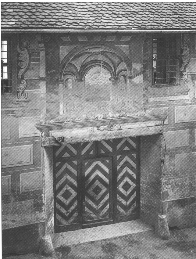
Abb. 1 Solothurn, St. Urbangasse 40, Fassadenmalerei, Zustand um 1925.
