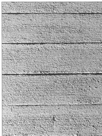
Abb. 6 Südfassade, Spritzbeton mit nachgeahmtem Schalungsbild.
