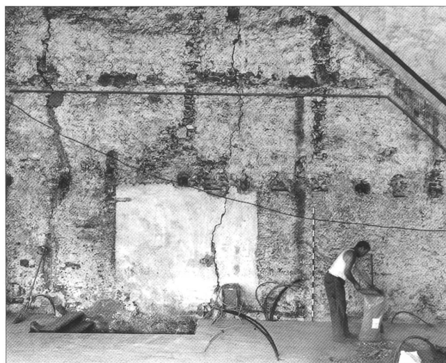
Abb. 7 Brandmauer Nord im Estrich nach dem Abbruch des Dachstuhls von 1657/58: Negativ einer älteren Ständerkonstruktion des Vorgängerdaches.
