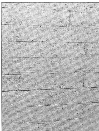
Abb. 3 Ostfassade, originale Schalungsstruktur, nach der Restaurierung 1999.
