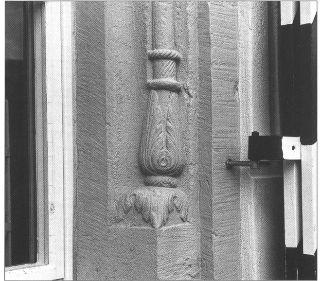
Abb. 4 Profil und Zierformen an einem Fenstergewände von 1587 am alten Schützenhaus in Solothurn.
