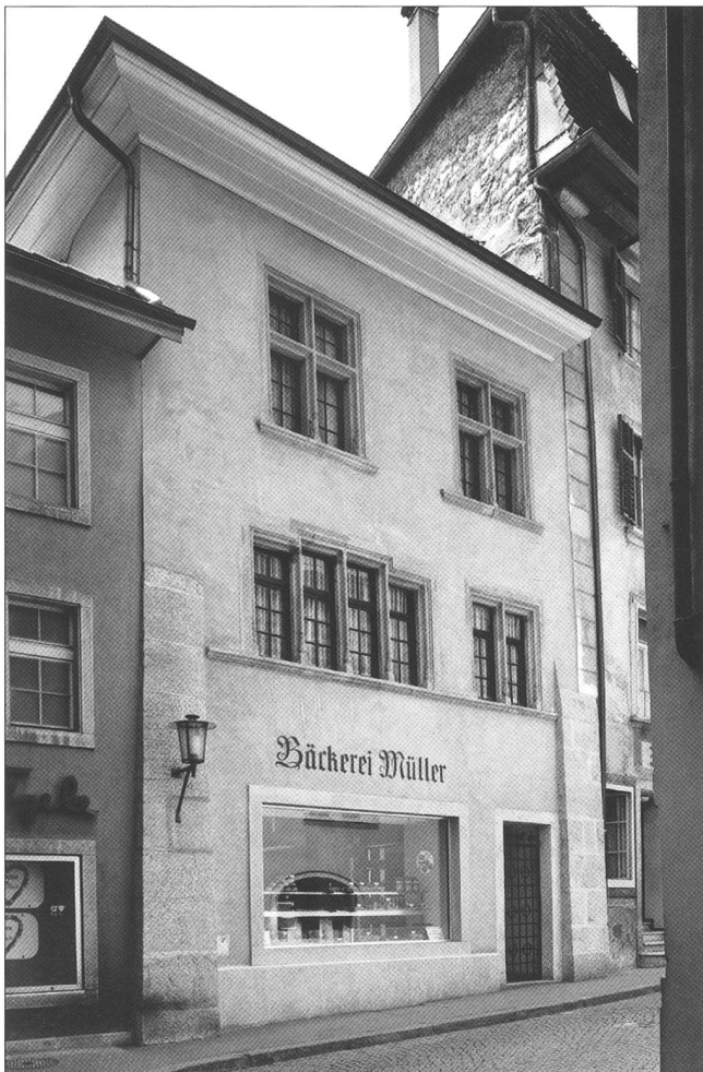
Abb. 1. Solothurn, Pfisterngasse 12, Gassenfassade nach der Renovation von 1973.
