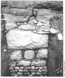
**Abb. 14** Halten/Turm zu Halten. Fundament des Turms auf der Nord-West-Seite.
