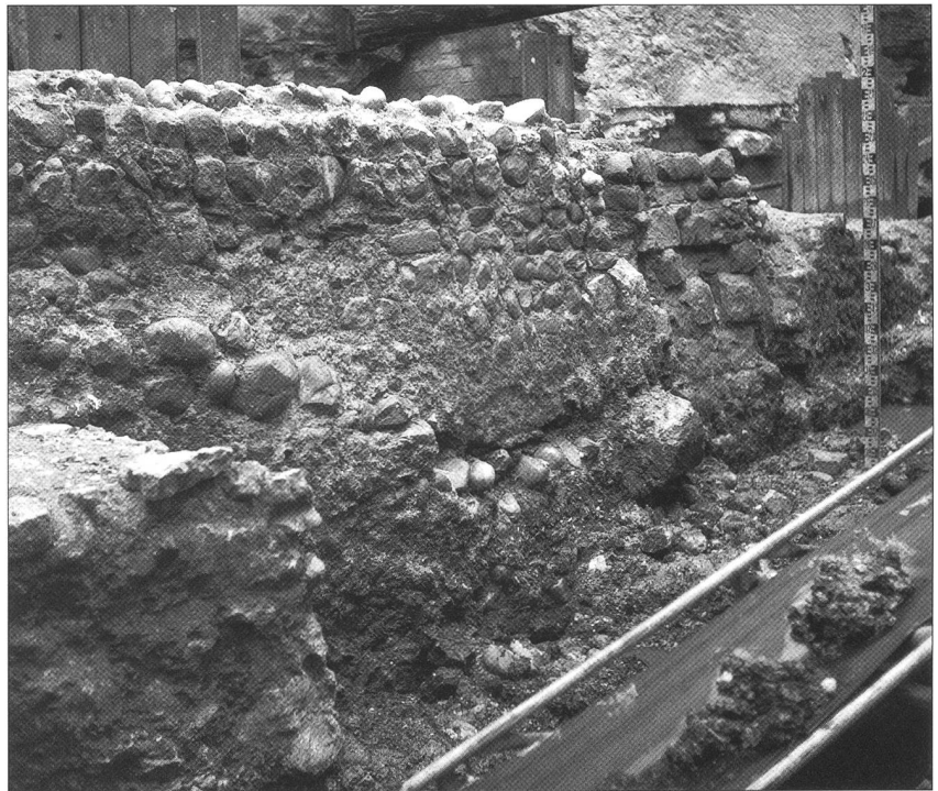
Abb. 21 Solothurn/«Roter Turm». Vorne links Mauer 4, dahinter Mauer 3. Links neben der Messlatte der offene Kamin. Neben dem grossen Eckstein des Kamins die nach links ansteigende Fuge in Mauer 3 (siehe auch Abb. 20).
