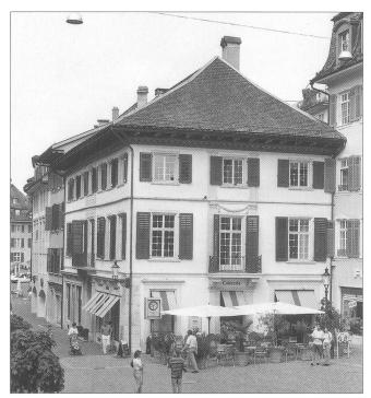
**Abb. 9** Das Haus nach der Restaurierung von 1997/98. Mit der Wiederöffnung der alten Hofeinfahrt und der Rekonstruktion des Trenngesimses zwischen Erdgeschoss und erstem Obergeschoss hat das Haus wichtige Gestaltungselemente zurückerhalten.
