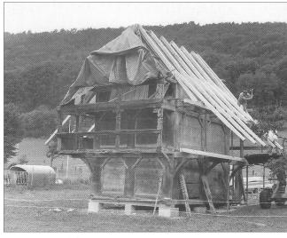
Abb. 4 Dacherneuerung am neuen Standort.
