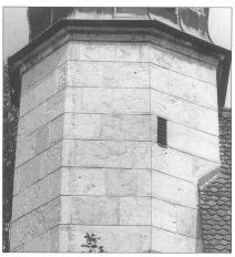
**Abb. 2** Detail des Turmes mit dem wiederhergestellten Fugenbild, nach der Restaurierung von
