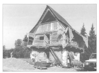
**Abb. 6** Der Speicher nach der Freilegung, das heisst nach Abbruch der Anbauten von 1923.
