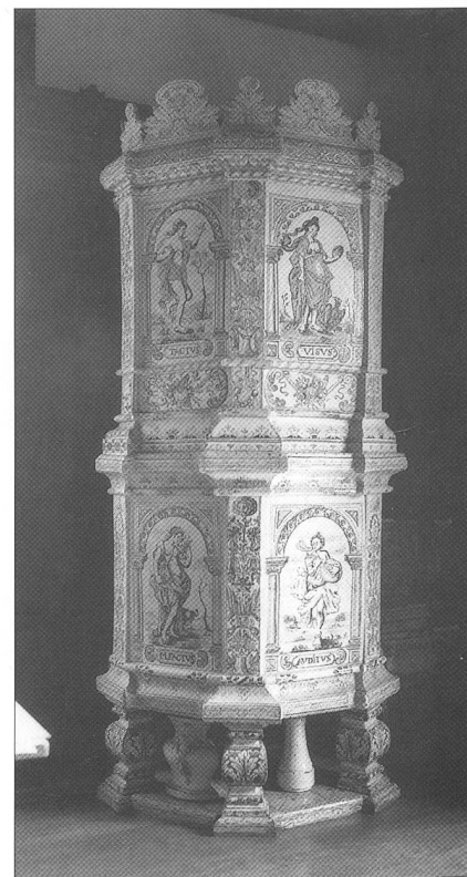
Abb. 19 Solothurn, Museum Werkhofstrasse, zweites Obergeschoss. Turmofen, zusammengesetzt aus Kachelmaterial verschiedener Öfen, vor dem Abbau 1994.
