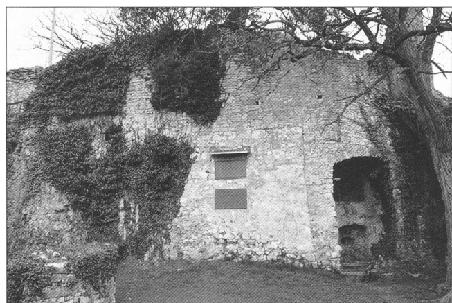
Abb. 16 Dornach, Ruine Dorneck. Innenseite (M1) des Grossen Bollwerks, Ausschnitt wie auf Abb. 15. Zustand 1998. Wenig links der stichbogig überwölbt Öffnung des Pulverturmes (T5) ist die südöstliche Ecke des kleinstenigen Mauerwerks (M1b) zu erkennen.
