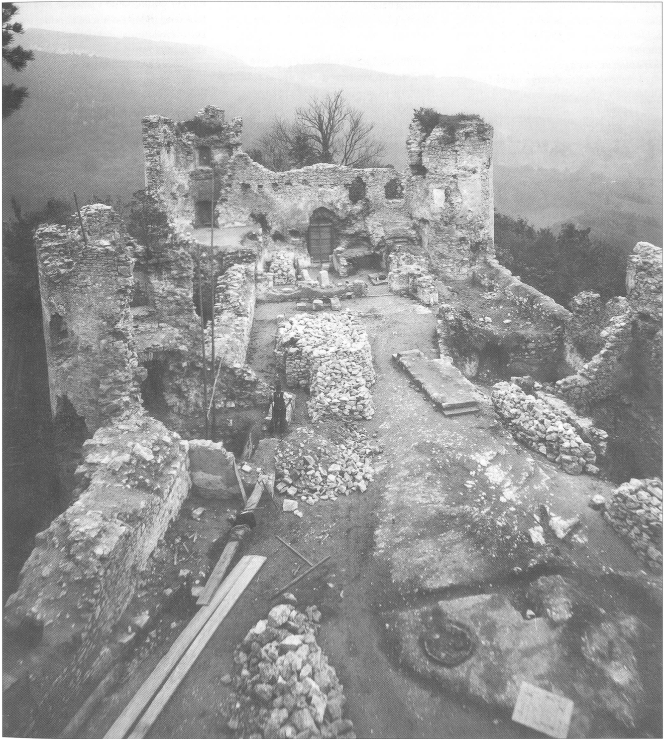
Abb. 51 Dornach, Ruine Dorneck. Unterburg, von Norden. Zustand während der Restaurierung (1904–1907/08) von E. Probst. Im Hintergrund: rechts der Hexenturm (T1) mit Hocheingang links oben, links der Doppelturm (T2/T3), zwischen den beiden Türmen der südliche Beringabschnitt (M5) der Unterburg. Vor dem Hexenturm ist der verschüttete Südkeller erkennbar.
