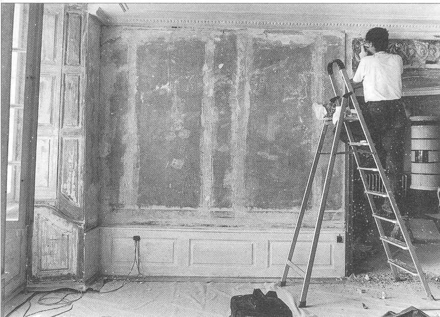
Abb. 7 Ausschnitt aus der Westwand des östlichen Zimmers während der Renovation. In der Wandfläche sind die Negative einer früheren Feldereinteilung zu erkennen.
