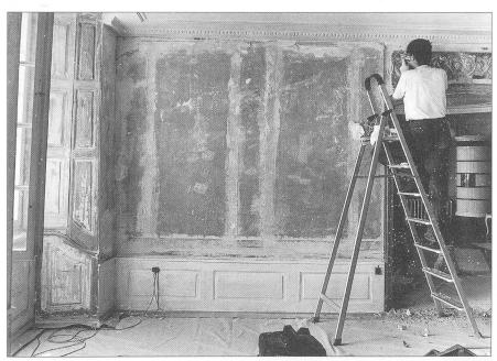
**Abb. 7** Ausschnitt aus der Westwand des östlichen Zimmers während der Renovation. In der Wandfläche sind die Negative einer früheren Feldereinteilung zu erkennen.
