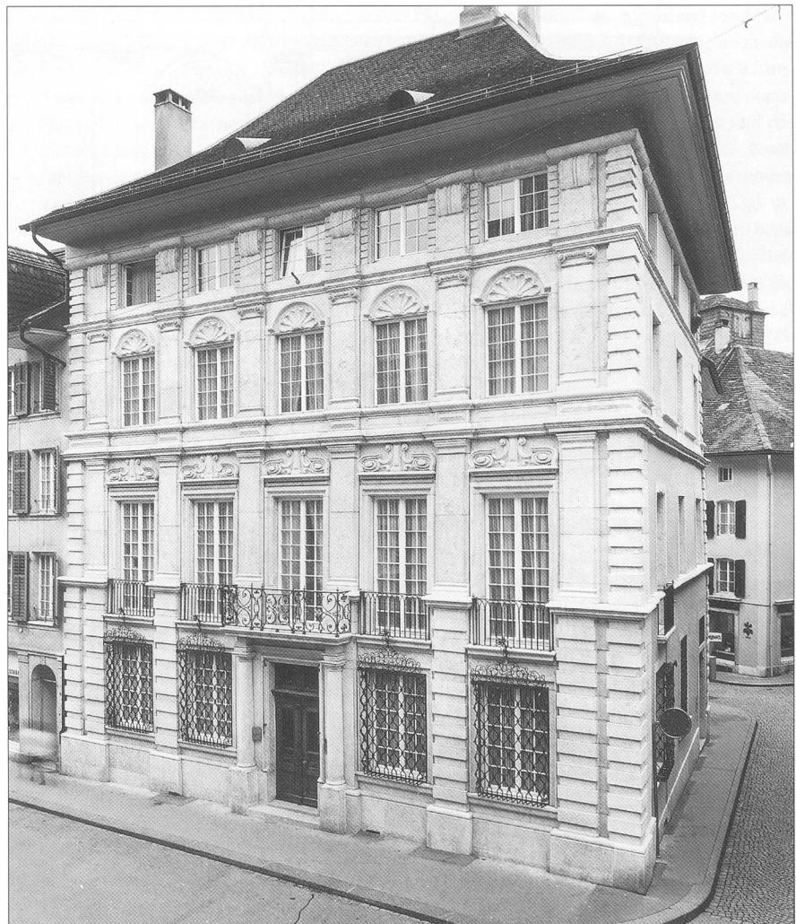
Abb. 3 Die Fassade nach der letzten durchgreifenden Renovation von 1974.
