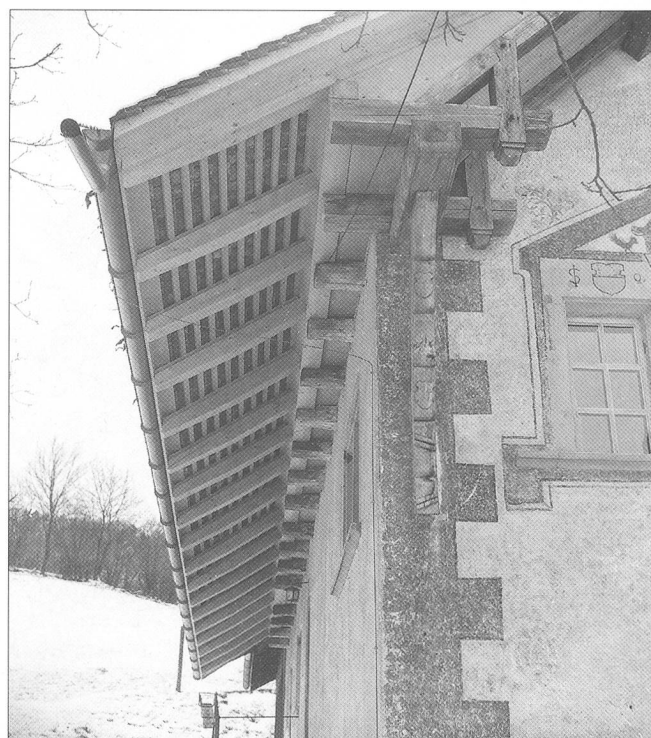
Abb. 2 Dachuntersicht mit erneuerten Aufschieblingen.
