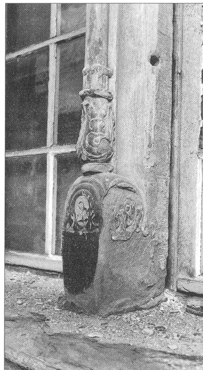
Abb. 4 Detail des Staffelfensters im zweiten Obergeschoss vor ...
