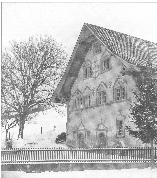
Abb. 1 Mümliswil-Ramiswil, Mühle, nach der Dachrestaurierung 1997.
