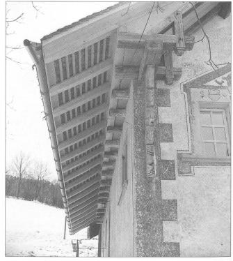
Abb. 2 Dachuntersicht mit erneuerten Aufschieblingen.
