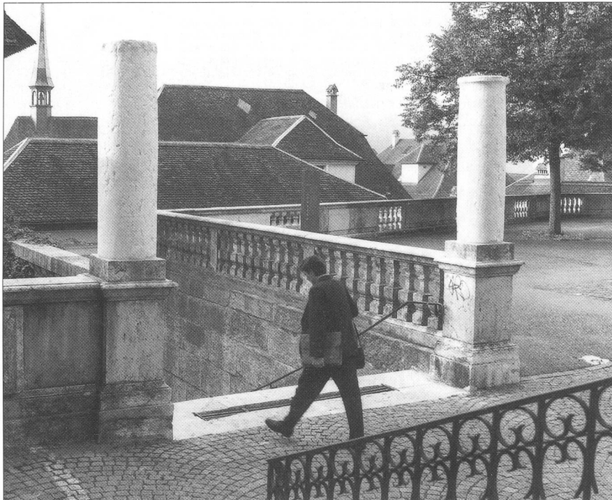
Abb. 8 Die Hermessäulen nach der Restaurierung und Replatzierung 1997.
