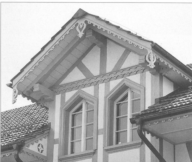
Abb. 5 Fassadendetails mit laubsägeartigen Verzierungen.
