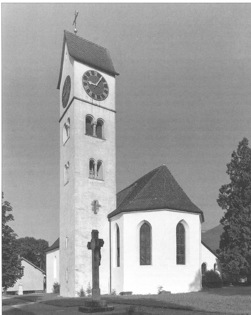
Abb. 1 Selzach, Pfarrkirche Mariä Himmelfahrt, Äusseres nach der Renovation von 1996.
