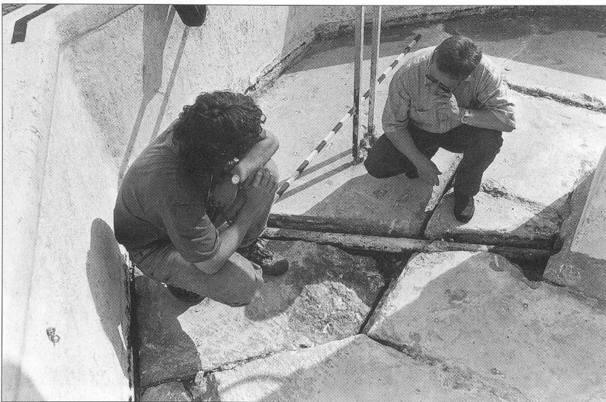
Abb. 5 Nach dem Entfernen des Betonbodens diskutiert der Denkmalpfleger mit dem Steinmetzen das weitere Vorgehen.
