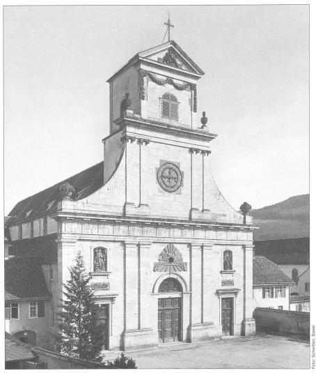
${\bf Abb.2} \ \ {\bf Fassade} \ \ vor \ der \ {\bf Restaurierung} \ \ von \ 1972/73. \ \ {\bf Die} \ \ roten \ \ {\bf Sandsteinquader} \ \ sind \ \ ungefasst \ \ und \ \ heben \ \ sich \ \ deutlich \ \ vom \ hellen \ \ Inzlinger \ \ Stein \ \ ab.$
