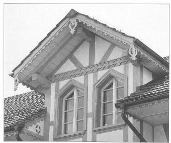
Abb. 5 Fassadendetails mit laubsägeartigen Verzierungen.
