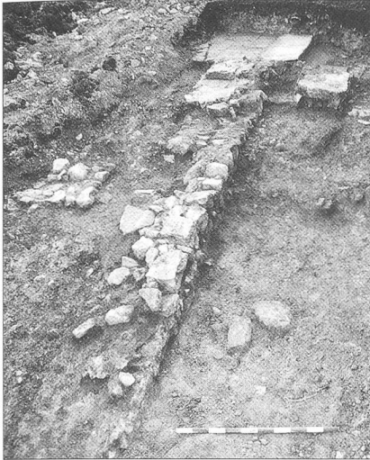
Abb. 7 Erschwil/Kirchgasse 54 (Scheuernmatt). Nordmauer M1 des Schiffes, links die Westmauer M3 der Sakristei. Gegen Osten.
