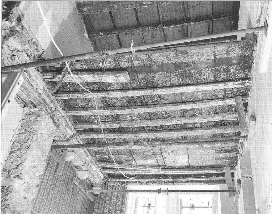
Abb. 6 Die Bohlendecke über der Stube im ersten Obergeschoss, Zustand vor der Renovation, 15. Mai 1992.
