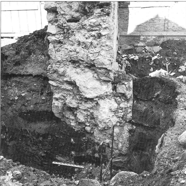
Abb. 7 Fundamentzone des südlichen Mauerabschnitts, aufgenommen 1963, nach dem Abbruch der Liegenschaft Patriotenweg 1. Die schräge Unterkante des Fundamentes wirft archäologische Fragen auf (sitzt die Mauer am Rand eines älteren Wehgrabens?).
