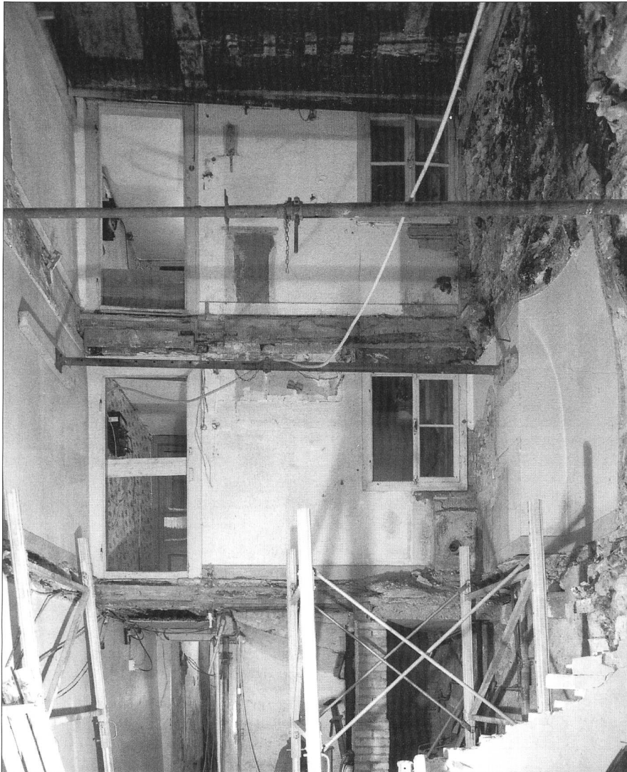
Abb. 2 Blick ins Innere des Hauses Schaalgasse 3 nach der Demontage der Balkendecken im Küchenbereich, 15. Mai 1992.
