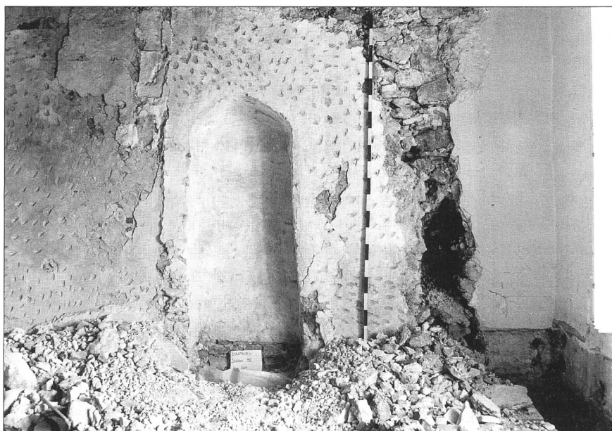
Abb. 5 3. Obergeschoss: Der ehemalige Durchgang, der trotz mehrmaligen baulichen Veränderungen die Lage des einstigen hölzernen Wehrgangs widerspiegelt. Im markanten Mauerriss rechts liess sich das Negativ des innern Mauermantels der 1782 abgebrochenen mittelalterlichen Stadtmauer fassen.
