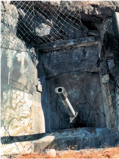
Schiessscharte Batterie West.
