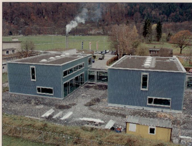
Rechts das Staffelgebäude, links das Ops-Gebäude. Im Hintergrund ist der Eingang zur Kaverne sichtbar.
