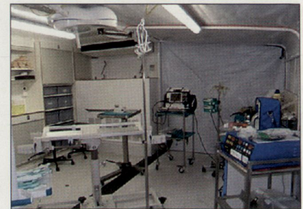
Installierter Sanitäts-Container (inkl. Generator, Wasseranschlüssen und Klimaanlage).
