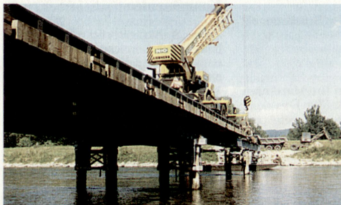
Stahlträgerbrücke mit Komponenten
