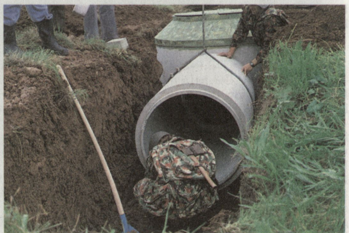
Bild 7. Eingebaute, noch nicht hinterfüllte Waffenstellung mit Anschlussrohr ( \varnothing_i = 1000 \text{ m} )
