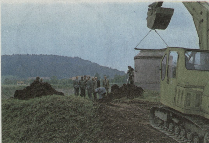
Bild 6. Transport der vorgefertigten Stellung vom Lastwagen zum Einbauort
