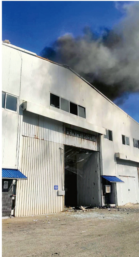
Diese Lagerhalle im Unifil-Hauptquartier wurde von einer Hisbollah-Rakete getroffen. Bild: UNO
