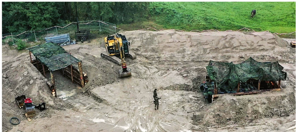
In der Sperrstellung wurden zwei Boxen für Schützenpanzer erstellt. Bild: G Bat 23
